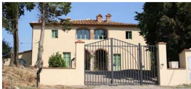
Castelrotto ristrutturato e, in basso, prima degli interventi
